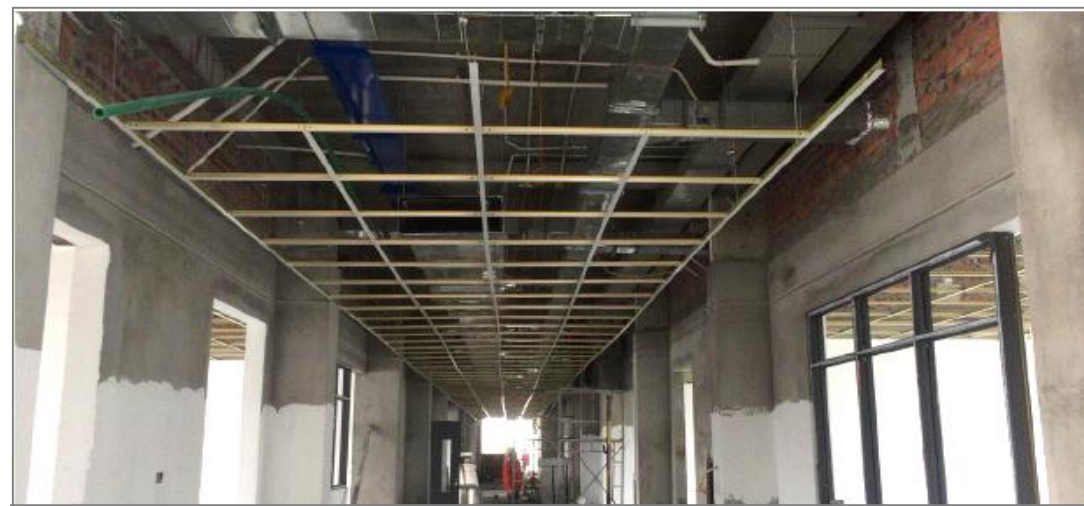
Công tác trát tường bên trong Khối nhà 2
