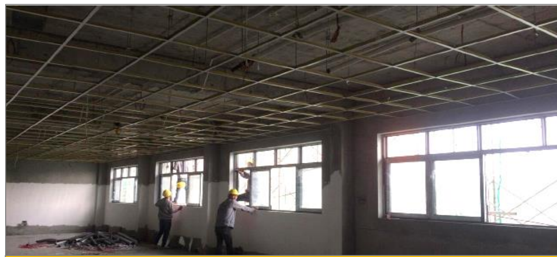
Công tác lắp dựng cửa sổ
